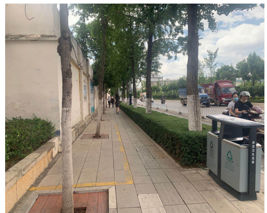
项目区西侧园博路城市污水管
