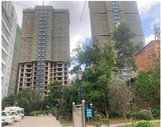
东侧在建小区
