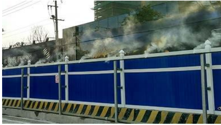
图 71 施工场地高压喷雾除尘示意图
