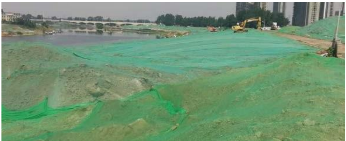
图 72 施工场地防尘网覆盖示意图
