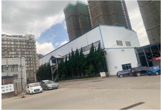
北侧-机动车六检站
