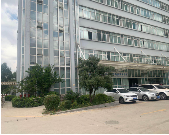
项目现状门诊楼
