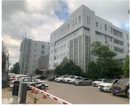
项目现状住院楼
