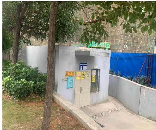
项目现状医废暂存间
