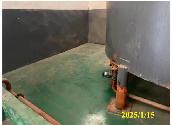
已建废矿物油储罐区围堰及防渗
