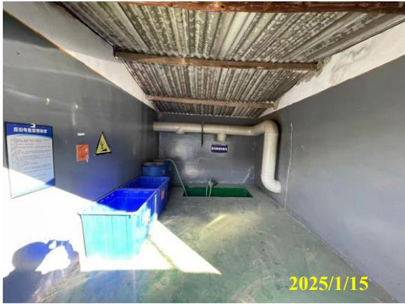
已建铅蓄电池贮存区废气收集装置
